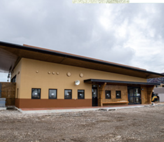
新たに整備された二次避難休憩施設
