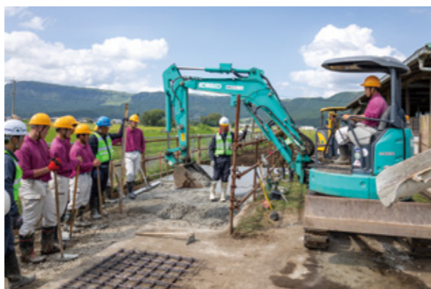
コンクリートを流し込む
