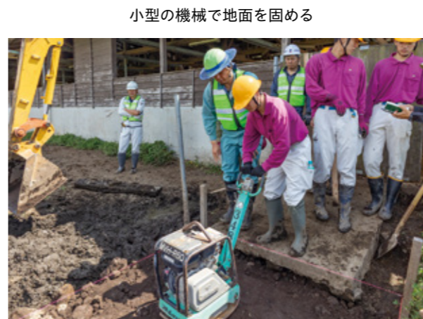
小型の機械で地面を固める
