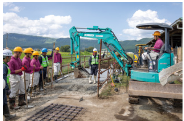
コンクリートを流し込む
