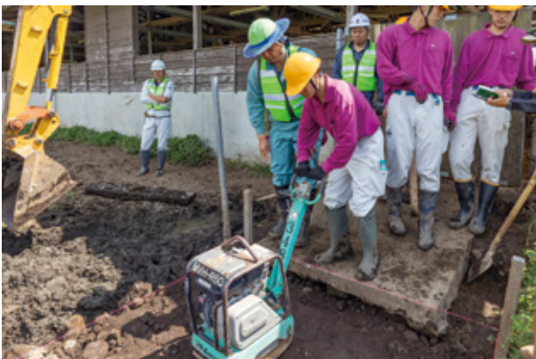
小型の機械で地面を固める
