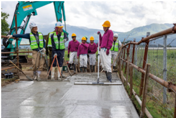
流し込んだコンクリートを丁寧にならす
