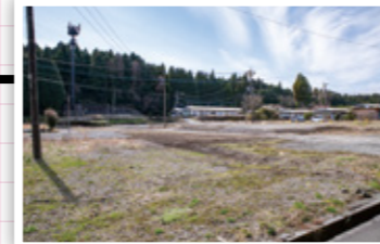
坊中南団地の建設予定地▶
