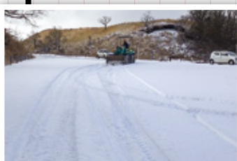
◀ 除雪作業の様子
