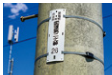
電柱の管理番号
