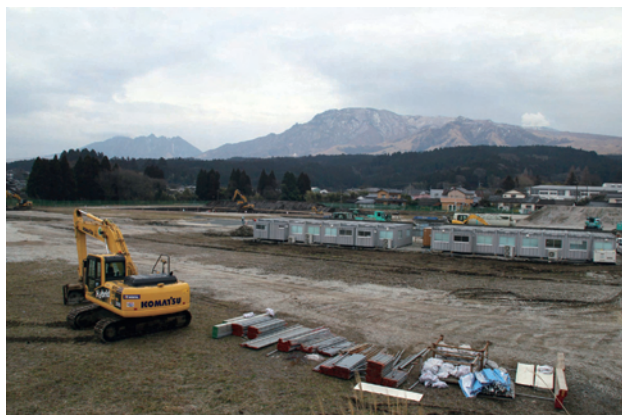
▲新築工事現場の様子。(旧阿蘇中学校跡地)。 ※工事期間中は、近隣住民の皆様には大変ご迷惑おかけしますが、ご理解とご協力をお願いします。
