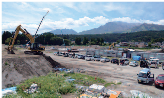
急ピッチで建設が進む阿蘇中央病院
