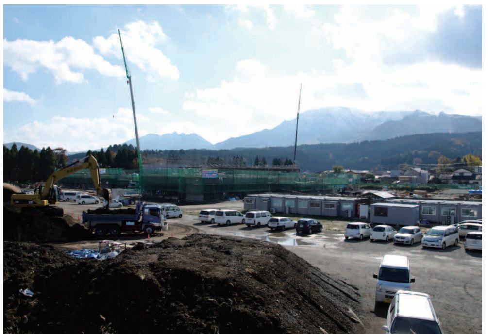
建設が進む阿蘇中央病院
