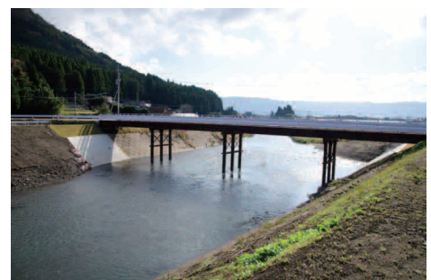
鷲の石橋の仮橋
