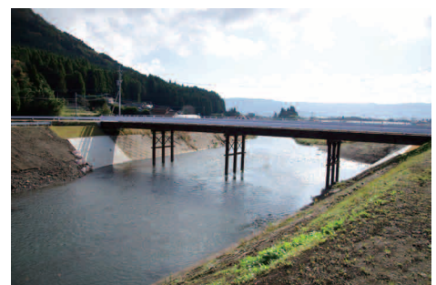
鷲の石橋の仮橋
