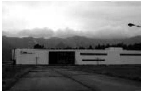
一部改修し、新しい企業が立地する赤水の工業団地。
