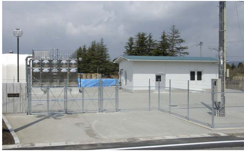
▲新設した「一の宮第5水源地」
