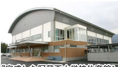
『完成した阿蘇西小学校体育館』
