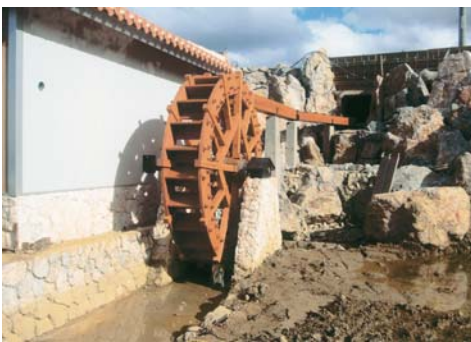
▲大型公園に設置された3.3mの水車 (写真は建設中のものです)
