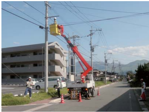
▲本年度完成予定の光ケーブル工事の様子
