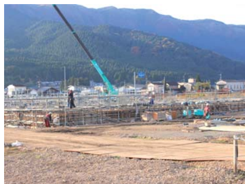
▲建設が進む阿蘇地区統合中学校（仮称）
