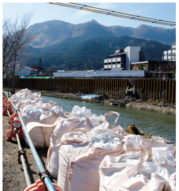
黒川河川改修工事のようす（内牧）
