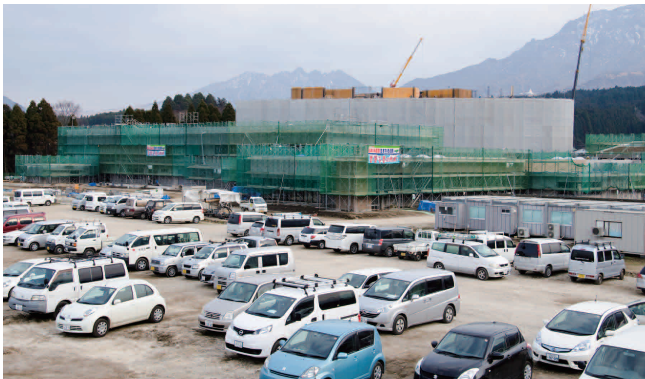
開院に向け、急ピッチで工事が進む阿蘇医療センター（次ページ参照）
