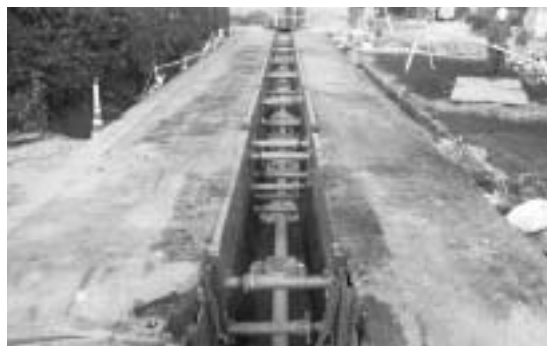
下水道の工事風景
