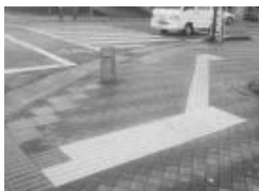
点字ブロックが整備されている交差点（宮地駅前）
