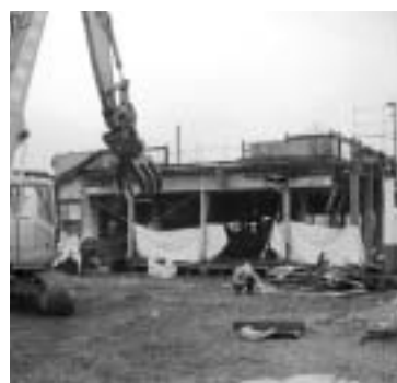
解体中の旧内牧支所
