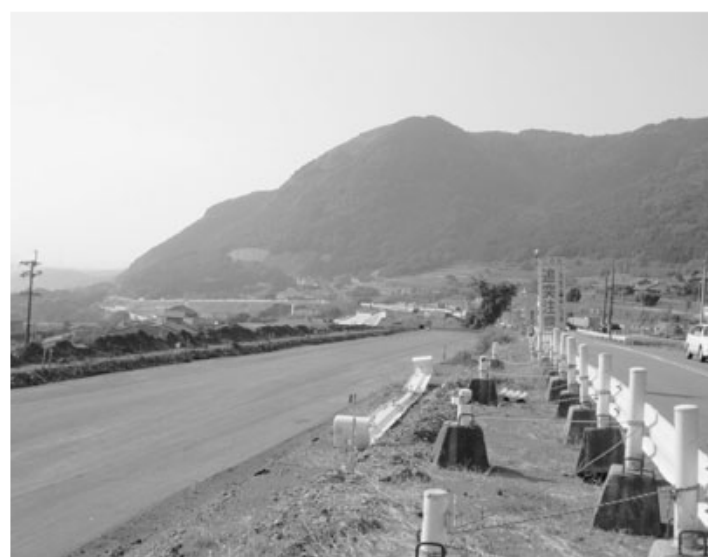
国道57号線4車線化工事(立野)
