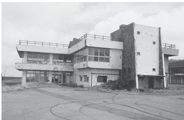
山上廃屋の撤去前
