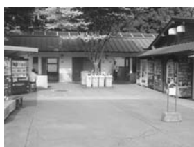
建て替えが予定されている道の駅「波野」の公衆トイレ
