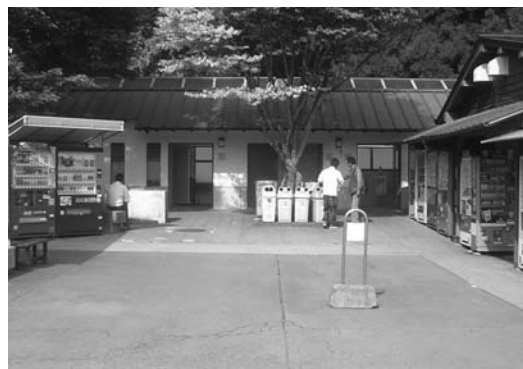
道の駅「波野」の公衆便所
