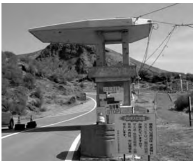
山上火口西口監視所
