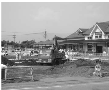
整備中の旧藤原旅館跡地
