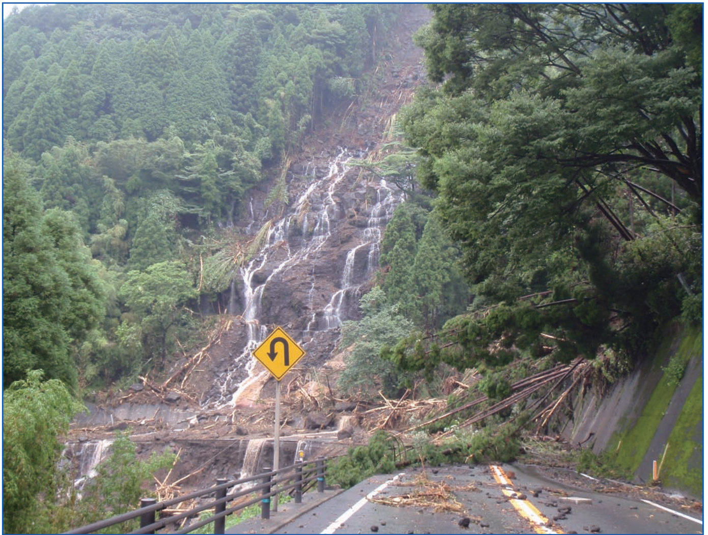
滝室坂崩落現場
