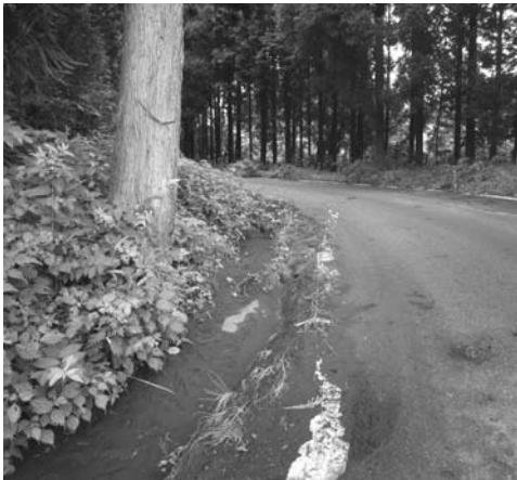
市道遊雀一釜割線(中間)道路側溝の状況
