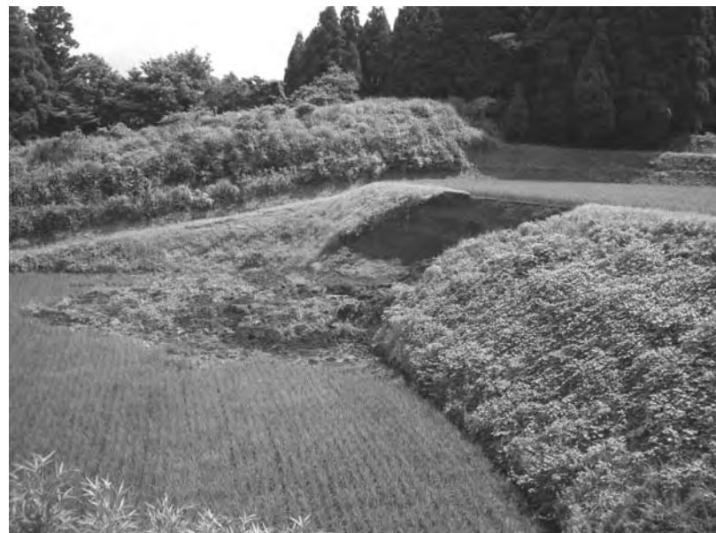
畦畔崩壊現場
