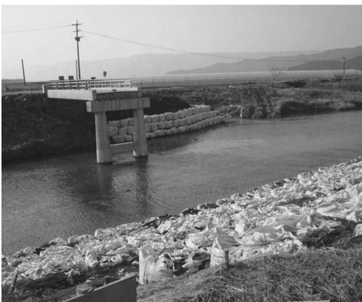
改修中の鷲の石橋
