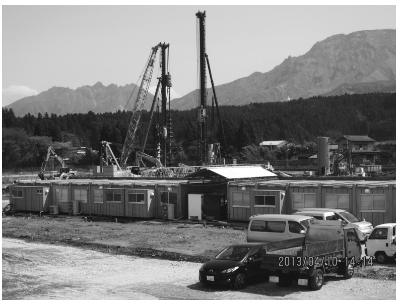
新病院建設現場
