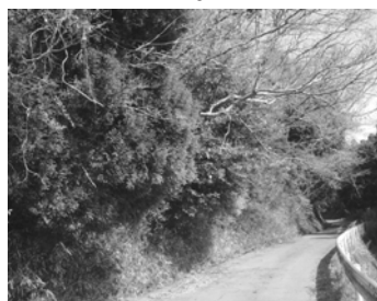
木落線の道路状況
