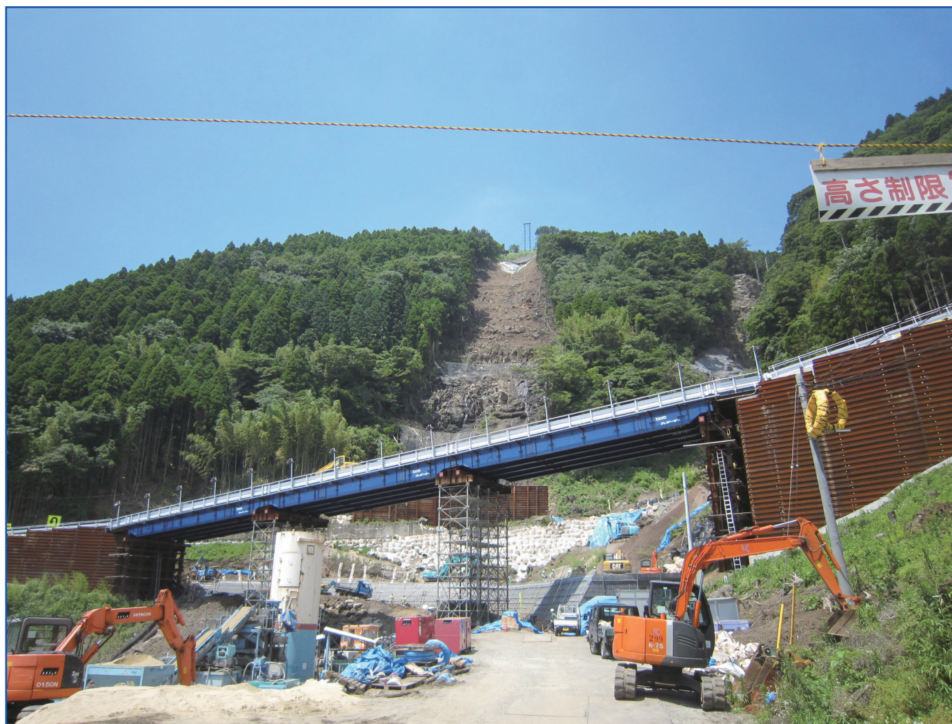
豪雨災害後の復旧工事が進む滝室坂付近（7月5日撮影）
