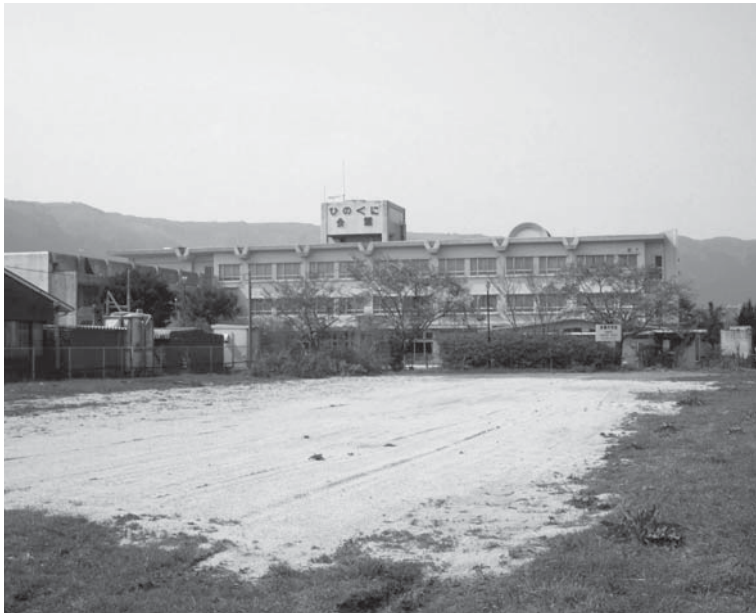
ひのくに会館駐車場
