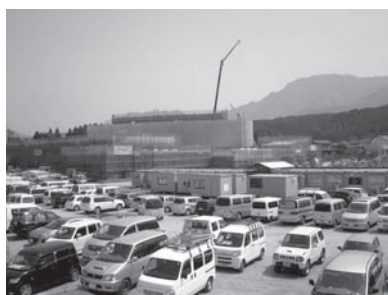
病院建設現場
