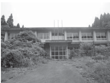
旧榑木野小学校校舎
