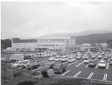
建設中の阿蘇医療センター
