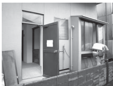
旧夜霧跡地のトイレ
