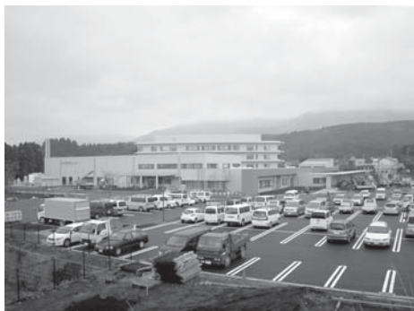
建設中の阿蘇医療センター
