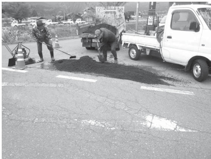
道路陥没箇所の補修作業の様子
