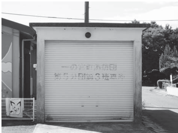
中通の移転対象ポンプ小屋
