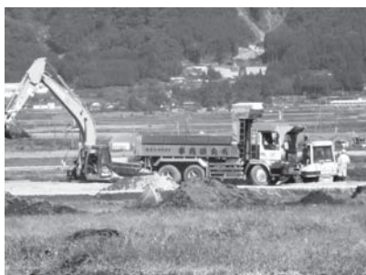
造成中の一の宮中グラウンド
