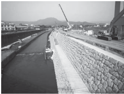
内牧河川改修の様子
