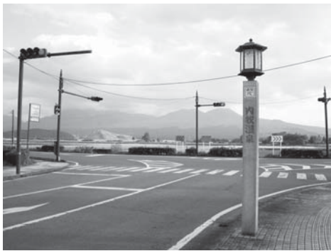
計画道路接続予定の三差路
