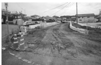
阿蘇医療センター進入路工事
