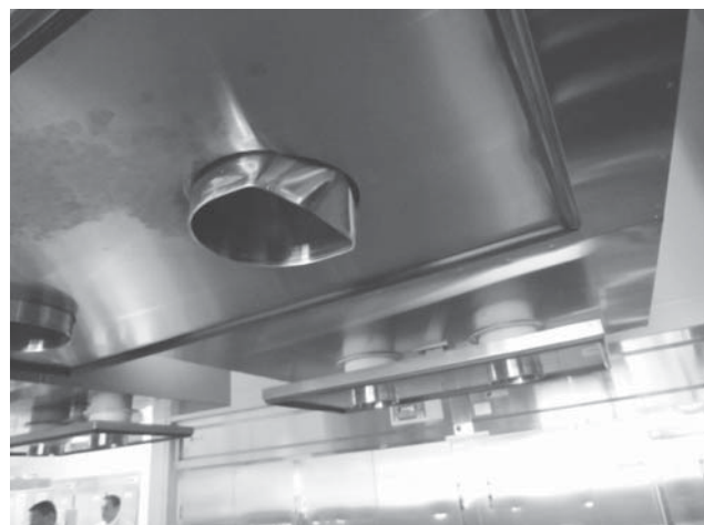
給食センター（乾燥機ジョイント部分）
