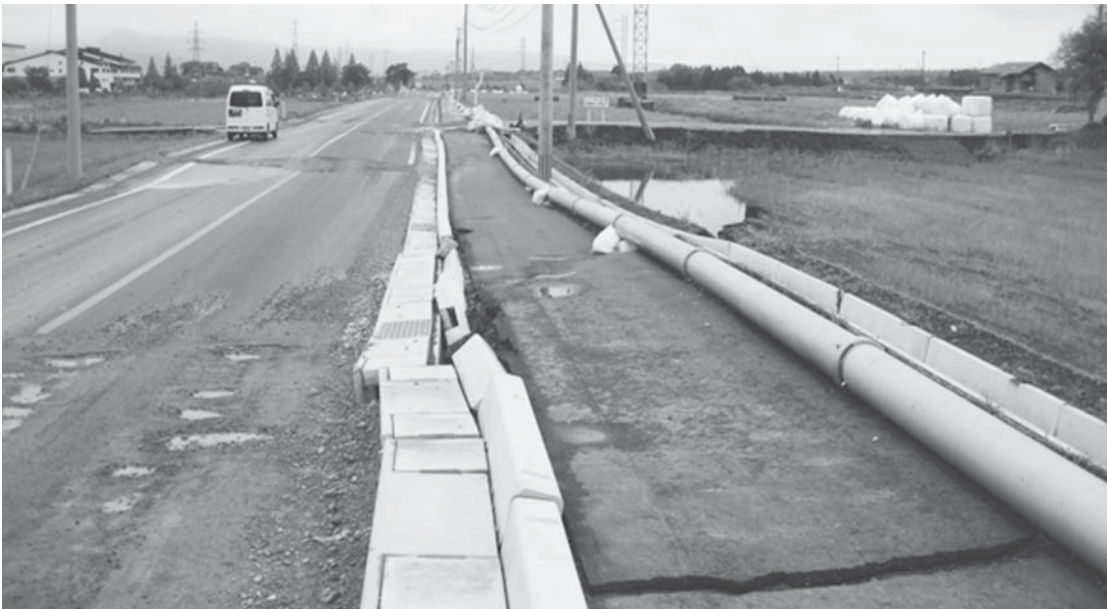
仮設の導水管（阿蘇西小学校前）
