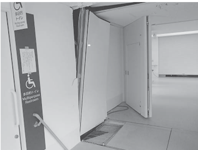
被害を受けた医療センターエキスパンション部分
