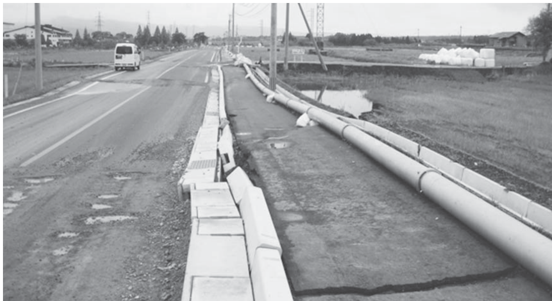
仮設の導水管（阿蘇西小学校前）
