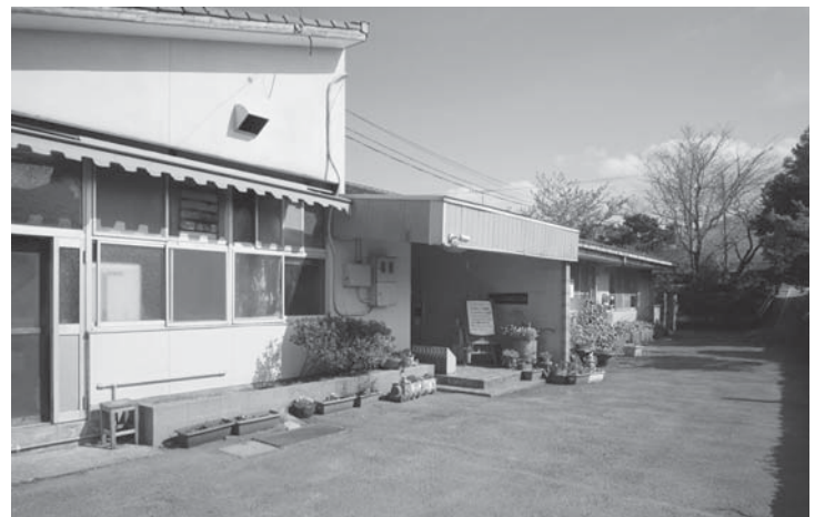
改修が予定されている宮地保育園
