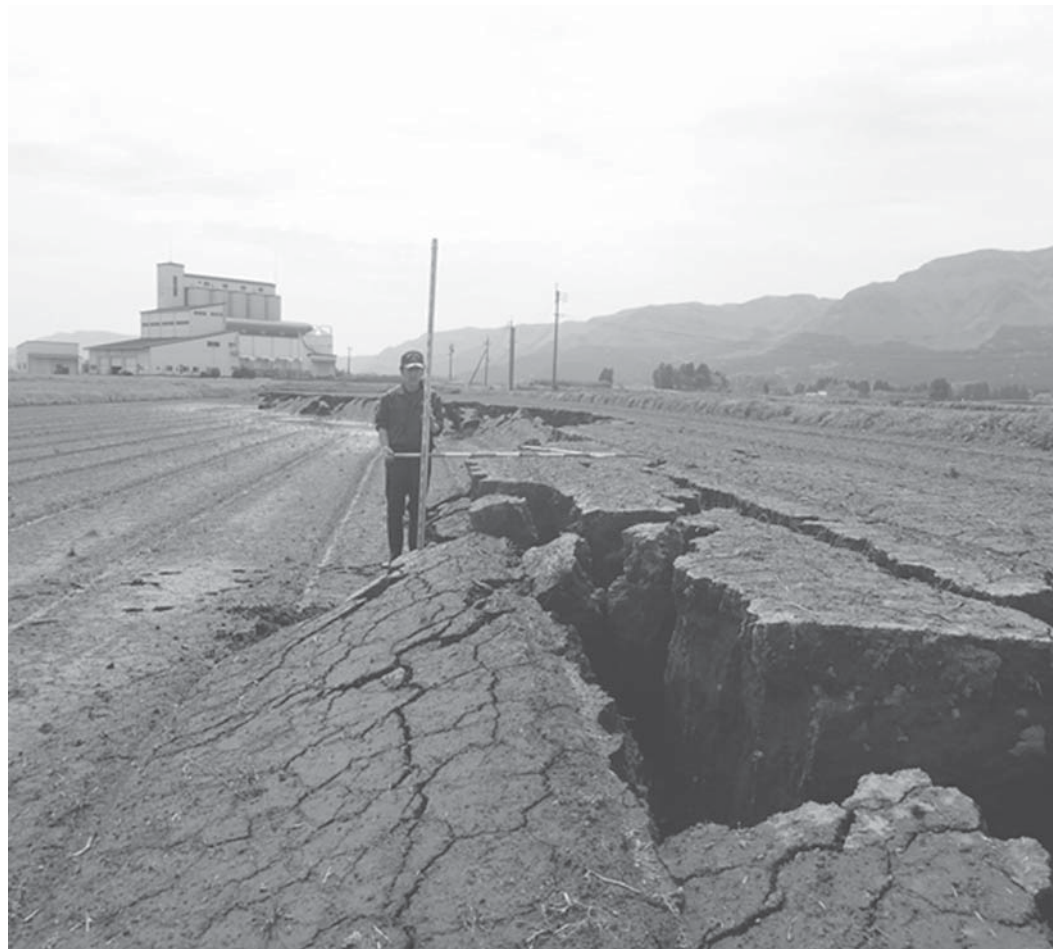
農地断層（狩尾地区）
