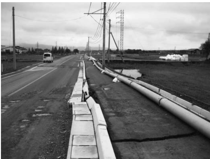
上水道仮設管（阿蘇西小付近）
