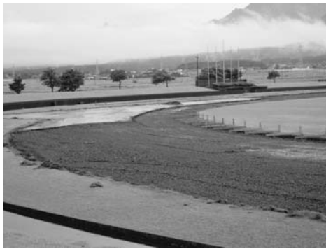
工事中の農村公園あびか（陸上競技場）
