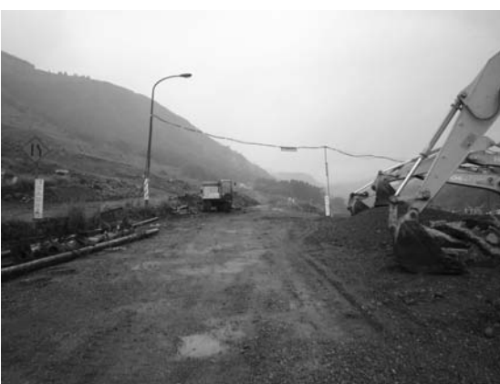
国道57号（阿蘇大橋付近）
