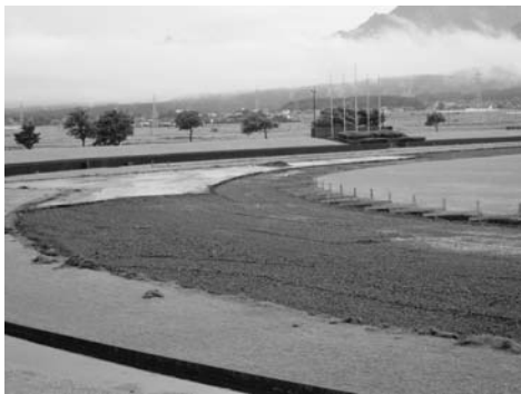
工事中の農村公園あびか（陸上競技場）
