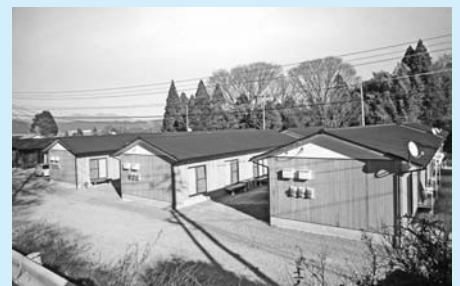
阿蘇市黒川団地（仮設住宅）
