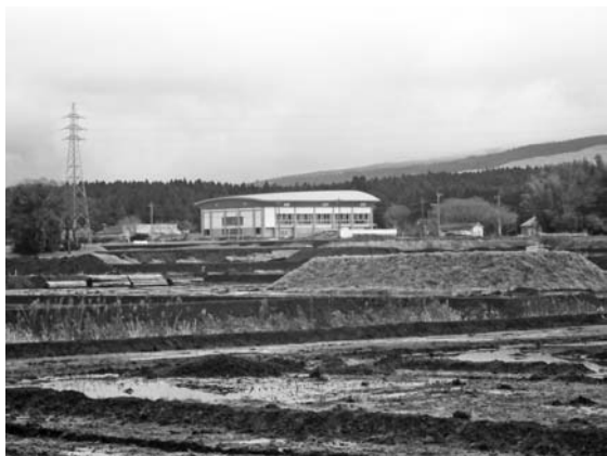
17工区の復旧状況
