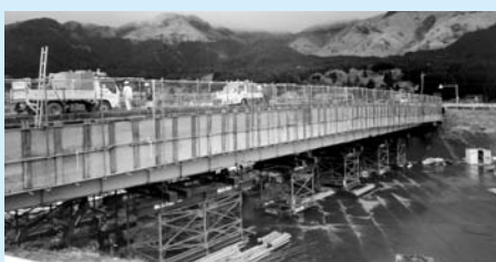
災害復旧工事中的大正橋
