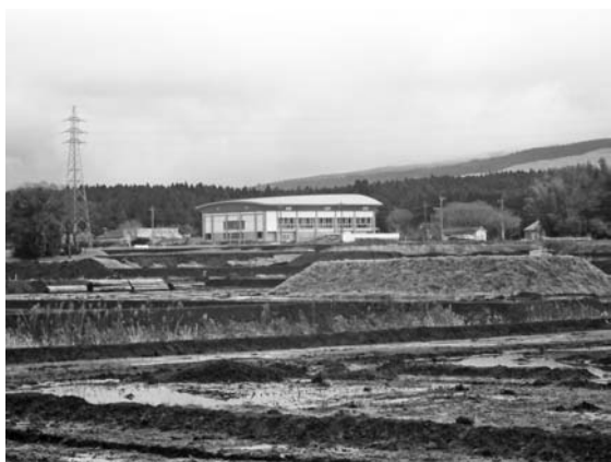
17工区の復旧状況
