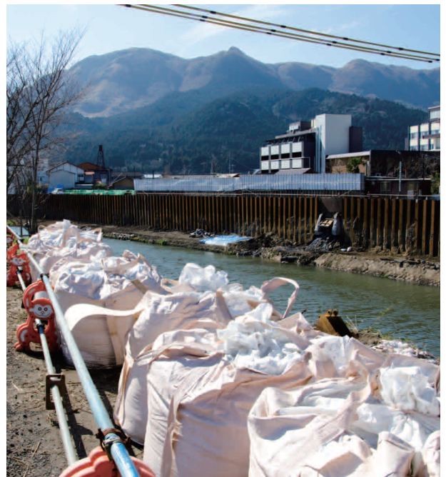
黒川河川改修工事のようす（内牧）
