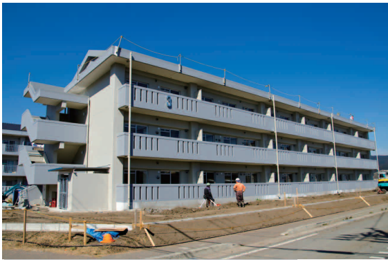
池尻団地は平成 26 年 3 月に 3 棟目が完成。 写真は市営住宅新小里団地（3 棟目）
