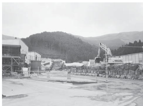
工事中の二重峠トンネル（阿蘇口側）
