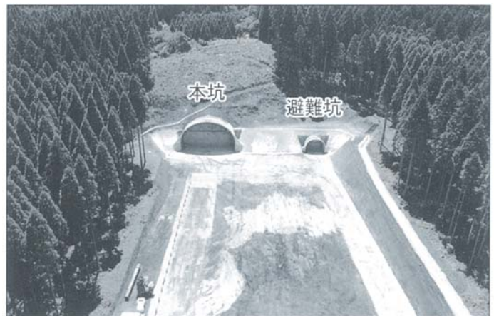
波野側坑口付近
