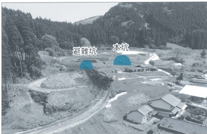
坂梨側坑口付近
